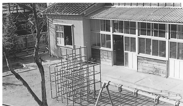
第1保育棟から見た屋外遊戯場
