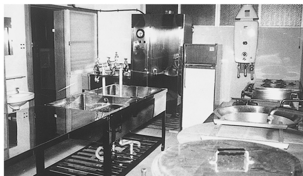
第1保育棟 給食室
